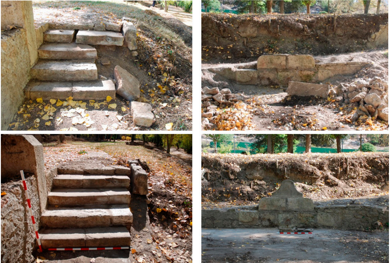
Fig. 2. Proceso de reparaciones en el entorno de la Fuente del Director.
