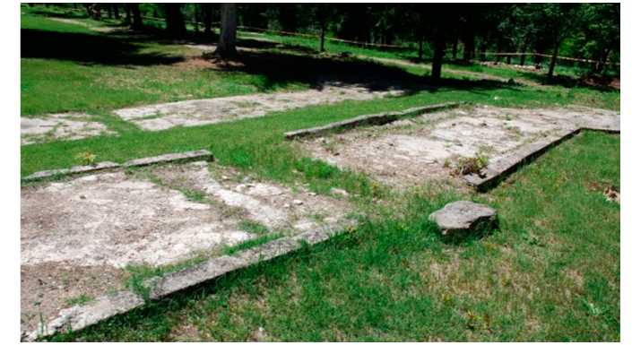
Fig. 5. Detalle del estado de conservación de los paseos del primer parque.
